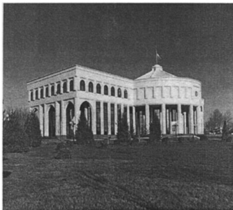
Beli Dom, Predsednička palata, ulica Afrosijob, Taškent, Uzbekistan, 5800 m 2 , izgrađen za šest meseci 1998. godine, vrednost projekta 18 miliona USD, Energoprojekt - Visokogradnja, Beograd
