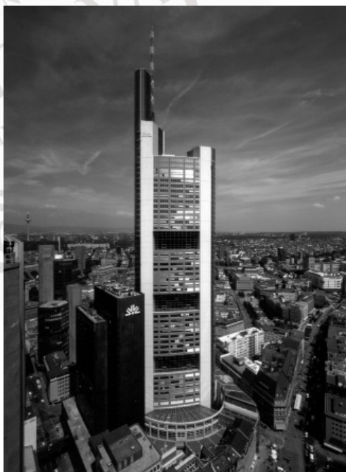
Poslovni objekat Commerzbank Tower, Frankfurt am Main, projekat završen 1997. Godine. Dobio British Construction Industry Award, 300 metara visine, najviša poslovna zgrada u Evropi,
